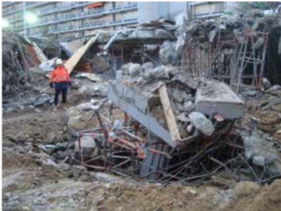
Abb. 4: Tagesbruch mit eingesunkener Betonstütze während der Abrissarbeiten.
